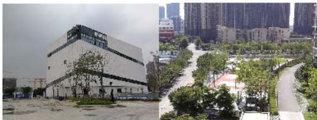
体育中心现场照片
