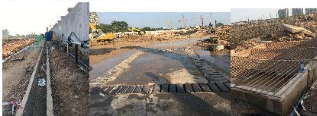
F1 已建临时排水沟
