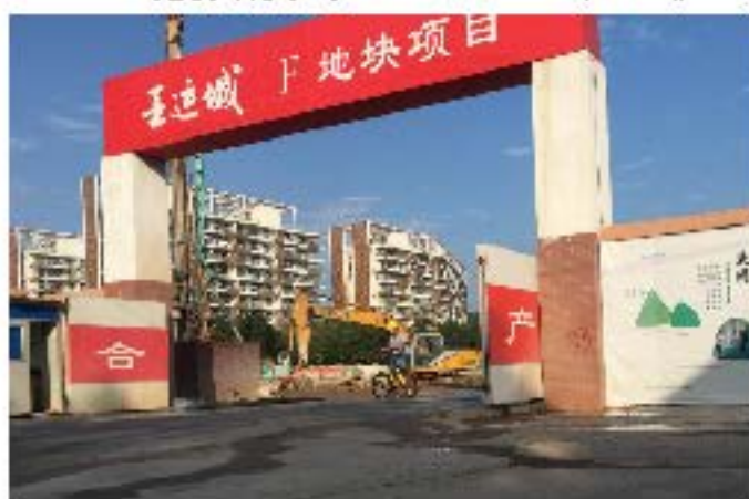
F2 施工出入口一
