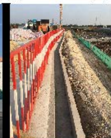
F2 临时排水沟
