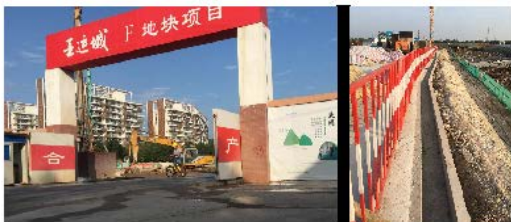
F2 施工出入口一
