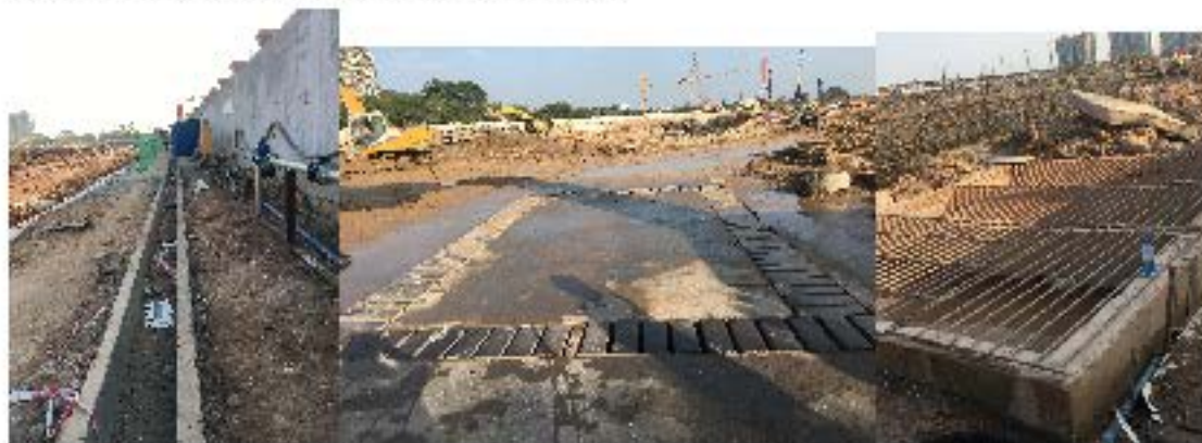
F1 已建临时排水沟
