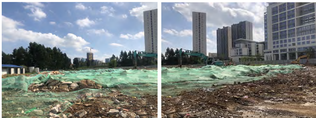
临时苫盖措施
