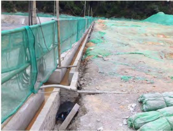
基坑顶排水沟和集水井
