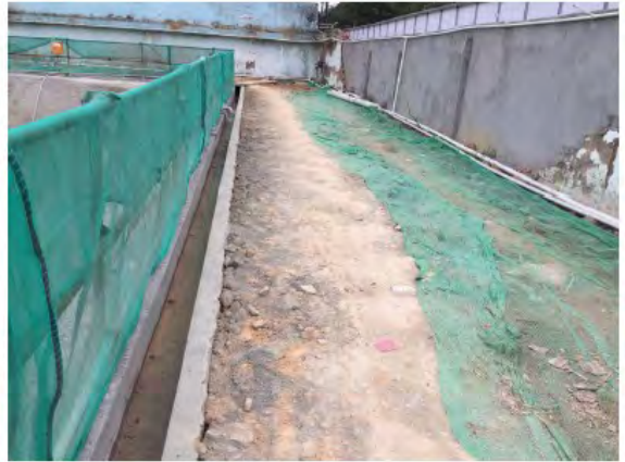
基坑顶排水沟和集水井
