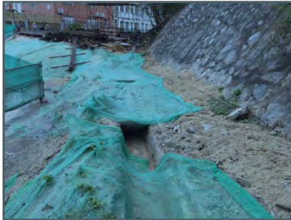
北侧坡脚排水沟
