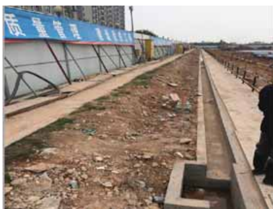
基坑排水沟和集水井
