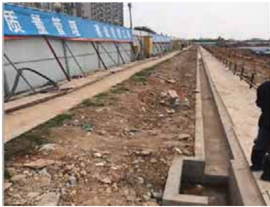
基坑排水沟和集水井
