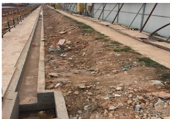
基坑排水沟和集水井
