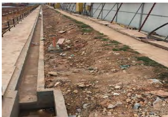
基坑排水沟和集水井
